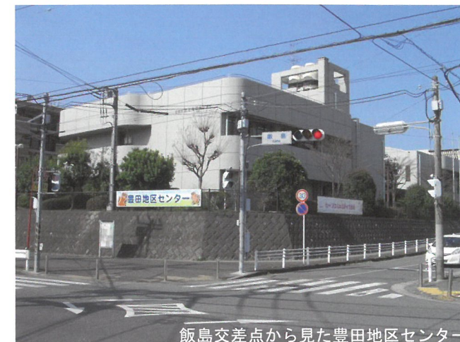
飯島交差点から見た豊田地区センター
